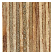
Plywood Edge Finish
